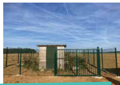
5» remplacement de la clôture et du portail du réservoir du Thoult-Trposnav
