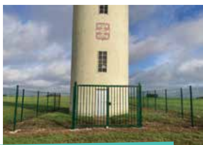
5» remplacement de la clôture et du portail du réservoir du Vézier
