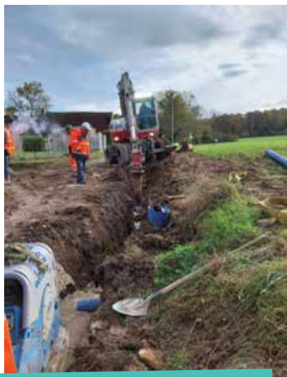
3» remplacement du réseau d'eau potable entre les hameaux des Bordes et de Soigny
