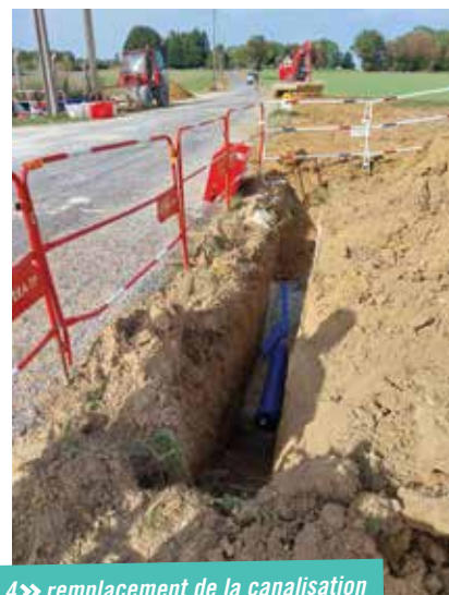
4» remplacement de la canalisation d'eau potable à Villeperdue
