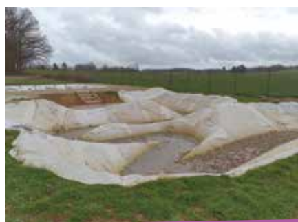
1» travaux d'assainissement collectif à Charleville
