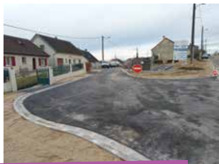
2» travaux rue des Vignes à Montmirail
