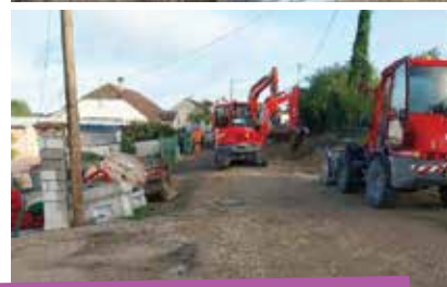
1» travaux rue des Vignes à Montmirail
