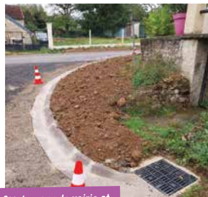
3» travaux de voirie et eaux pluviales au Vézier
