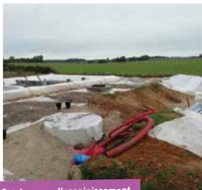
2» travaux d'assainissement collectif à Charleville
