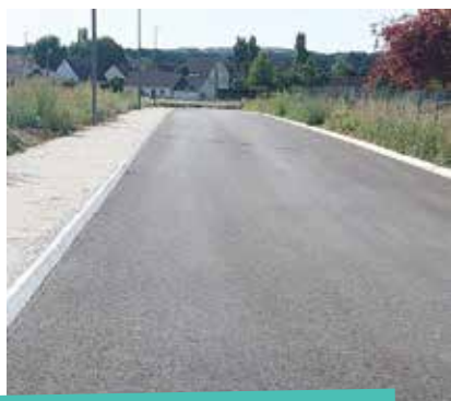
1» travaux de voirie en ZI de Mondant à Montmirail
