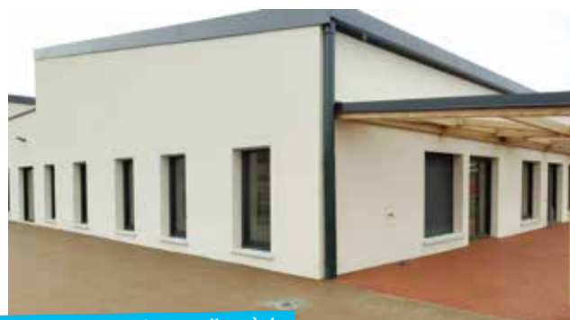
la cour arrière de la nouvelle crèche
