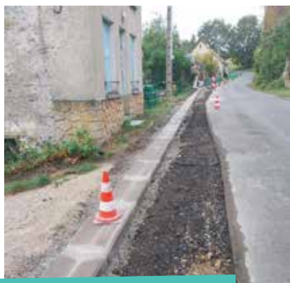
2» travaux eaux pluviales à Verdon
