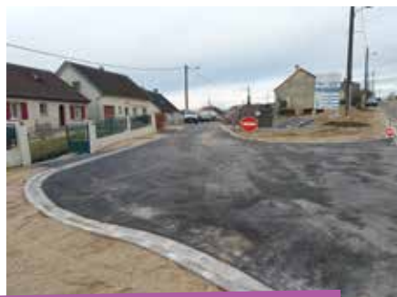
2» travaux rue des Vignes à Montmirail
