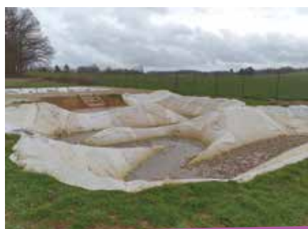
1» travaux d'assainissement collectif à Charleville
