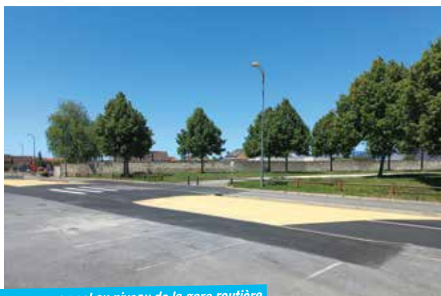
marquage au sol au niveau de la gare routière
