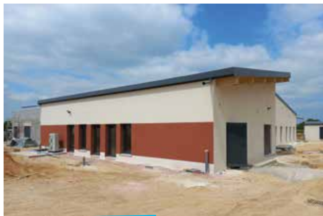
avancée des travaux au 15 mai 2025
