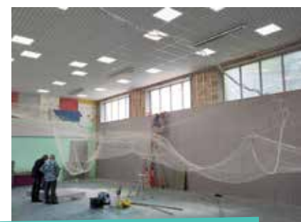
4» isolation thermique du gymnase de l'école élémentaire de Montmirail
