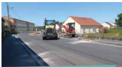
2» travaux de voirie rue de la Croix-Gaudé à Montmirail
