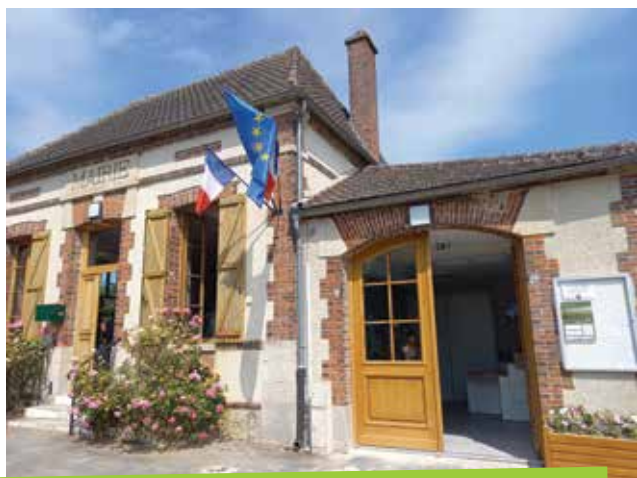
rénovation intérieure et remplacement des menuiseries extérieures
