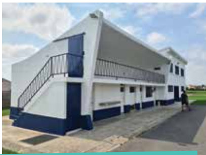
8» ravalement de façade et peinture des murs du bâtiment du football à Montmirail
