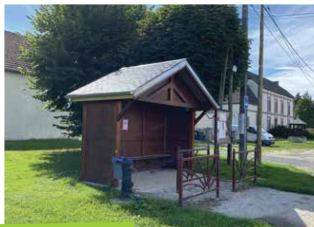
l'abribus et son nouveau toit
