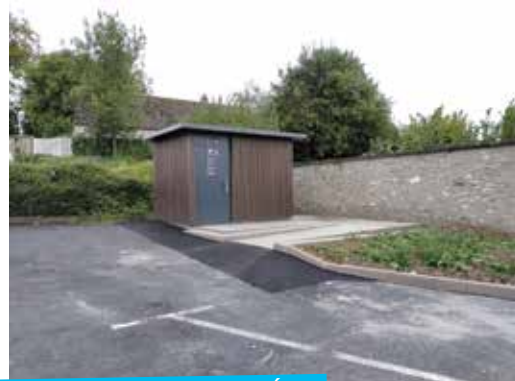
nouveaux sanitaires place de l'Église
