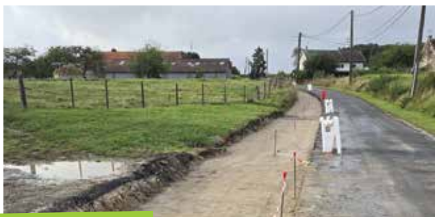
travaux rue de la Dhuis
