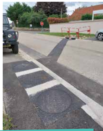
4» travaux de voirie et assainissement pluvial rue de Beaumont à Montmirail
