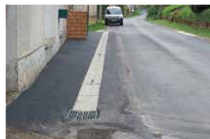
5» travaux de traverse de chaussée et pose de CC1 à Verdon
